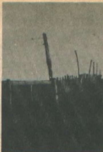
Foto 5. Línea madre llevada paralela al alambrado, con postes cada 45 mts.
