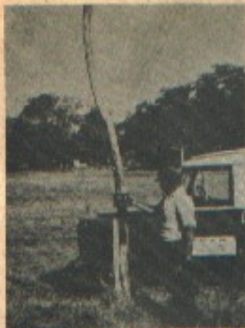
Foto 2. Bajada de la línea madre a la de baja, con una llave de corte, para poder trabajar más cómodo.
