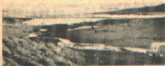
Tajamar de aguada de 3 metros de altura de agua, construido en una cárcava existente; con cañería de utilización de 2" para un campo de 700 hás.
