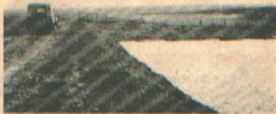
Desagüe artificial de un tajamar de riego, correctamente compactado.
