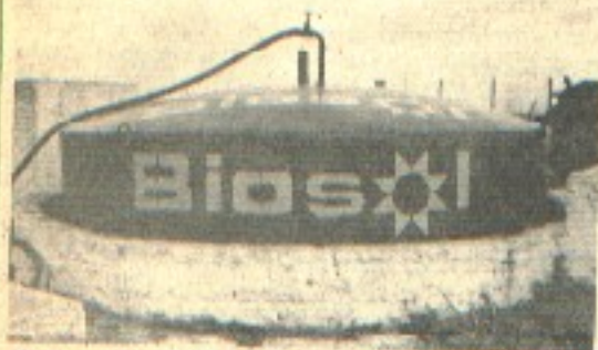
Primera Planta de Producción de Biogás del Uruguay, en funcionamiento ininterrumpido por más de 5 años en su estado actual
