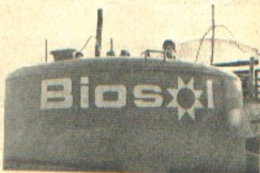
Planta de Biogás recientemente inaugurada
