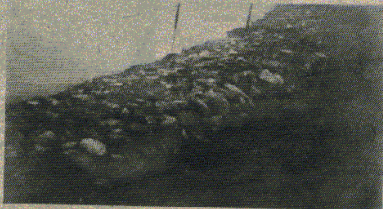
Foto N° 7. Enrocado parcial del talud aguas arriba, apoyado sobre material granular.
