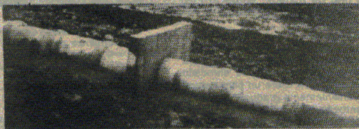
Foto N° 3 Caños de hormigón asentados sobre material natural bien consolidado y una toaca cementada, más el «collarín antifiltrante» para dar anclaje al caño e impedir filtraciones a lo largo del mismo.
