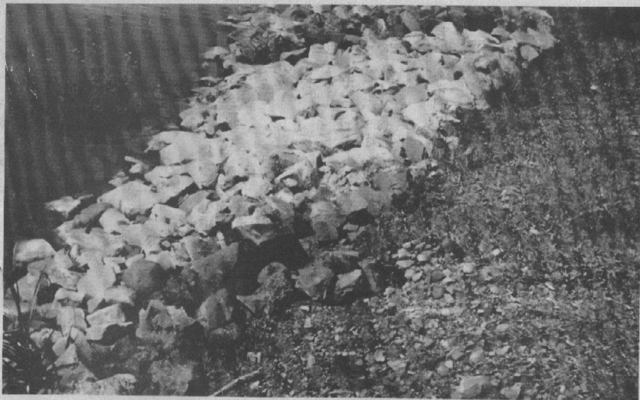
Foto 6 - Detalle del enrocado del embalse anterior, apoyado sobre material granular.
