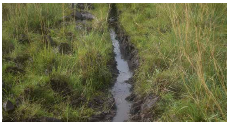
Foto 2. Canalización del terreno para drenar la humedad.
