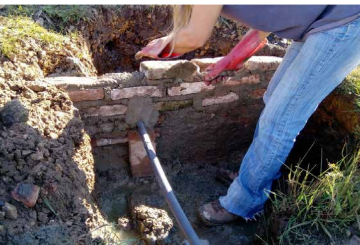
Foto 4. Acondicionamiento de la vertiente; pared en ladrillos e instalación de tuberías
